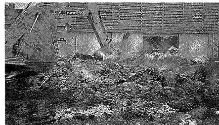
(b) 油圧ショベルによる土質改良
