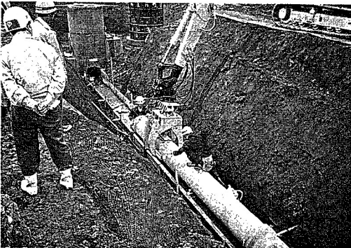
写真3 管ハンドリング機による管敷設作業
